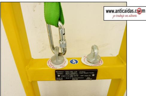
Anclajes de cáncamos Uno para trabajos con anticaidas. Dos para trabajos verticales Un cáncamo: Sistema anticaidas un cáncamo: Sistema suspensión. Cumple la Norma EN 795 clase B
