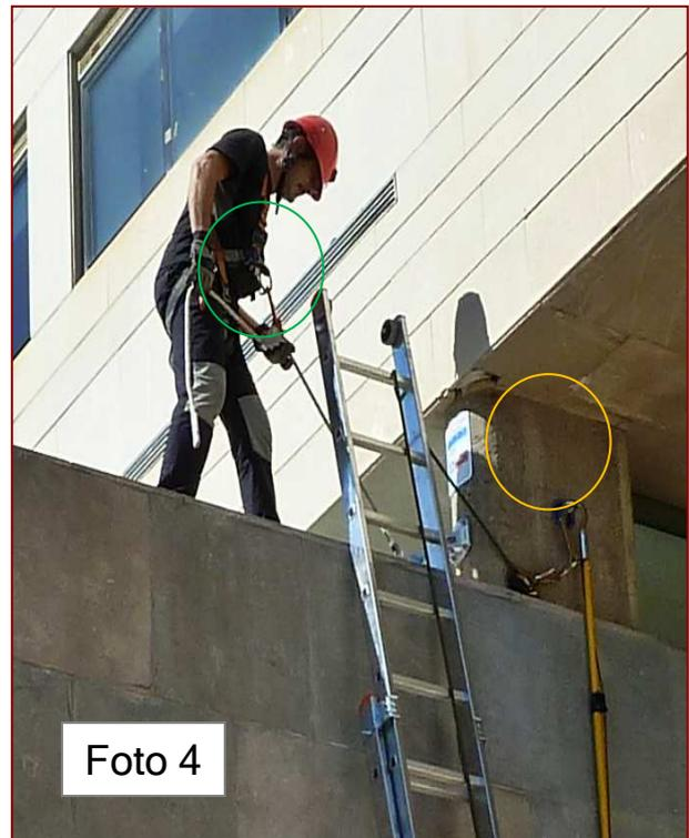
❑ Foto 3 y 4. Antes de abandonar la cuerda del sistema anticaídas deslizante (círculo amarillo), conectar nuestro sistema anticaídas (círculo verde) a la línea de anclaje horizontal de cable.
