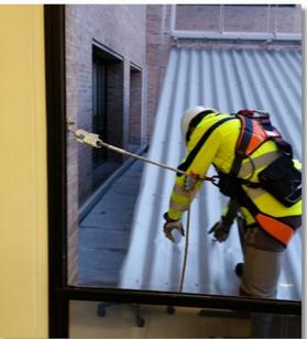
Antes de empezar a trabajar sobre el techo hay que asegurarse al punto de anclaje existente en el paramento de la ventana ya que existe el riesgo de que se rompa.
