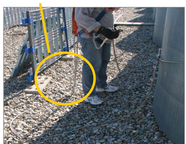
Conexión absorbedor-cable
